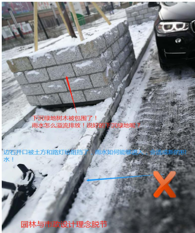
错误做法2: 传统的园林绿化没有和海绵城市进行良好结合，导致下沉式绿化带种植严重阻水，使下沉式绿化带、溢流式收水口等设施失去了意义；换填土的质量令人质疑，存在大直径的土块，与设计要求的换填要求存在明显差异，并且普遍缺乏维护致使垃圾堆填。
