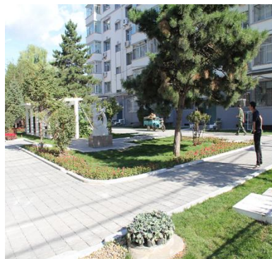
下沉绿地+缝隙透水人行道+线性排水沟+碎石缓冲带
