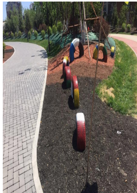
采用美国常用的树皮材料作为覆 盖物铺装，增加雨水入渗饱和能力。
