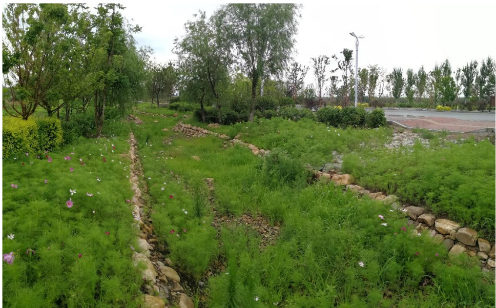
纵十三路生态沟渠径流行泄通道（道路低点人行道路设置径流通道与生态沟渠连接）
