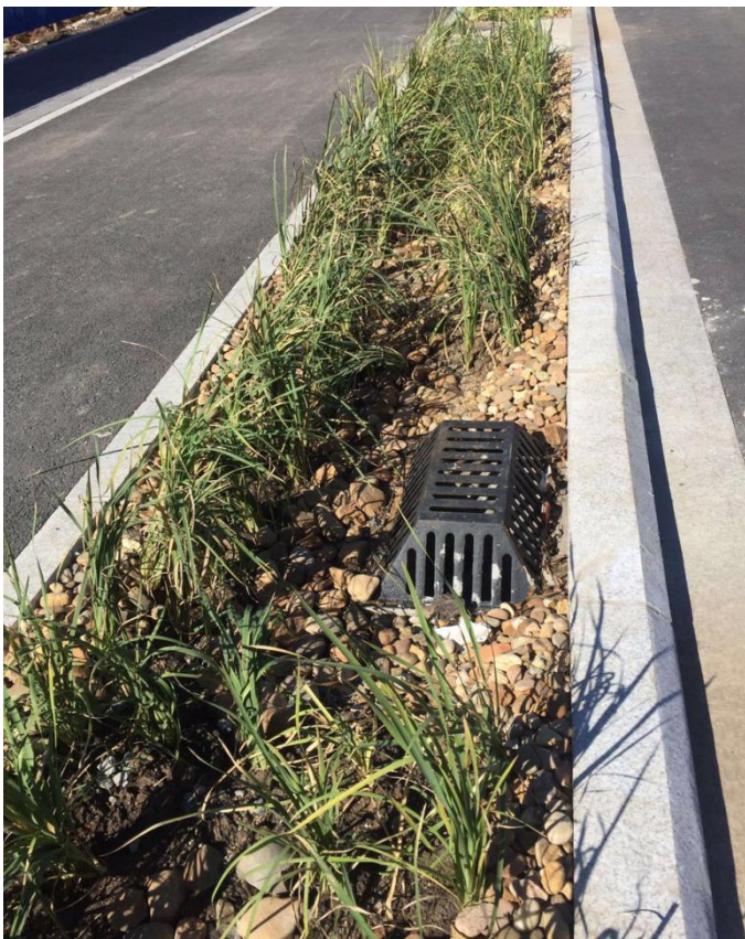
透水非机动车道、缝隙透水砖铺装、下沉式绿化带实际工程图
